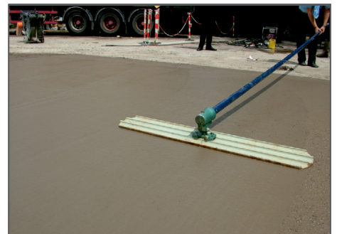
3 ansteckbare Stielteile (insgesamt 5,4 m) und einfache Handhabung.
