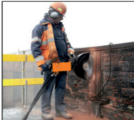
Hydraulischer Direktantrieb. Schneidet schnell und präzise Beton, Stahlbeton, Asphalt sowie Stahl.
