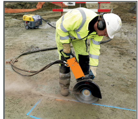
Verwendbar mit Diamanttrennscheiben für Trocken- und Nassschnitte sowie abrasiven Stahltrennscheiben. Einsetzbar in staubiger Umgebung, im Schlamm sowie Unterwasser.
